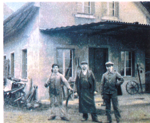
Bildlegende StÜ: Bild von der Hinweistafel am Gebäude
