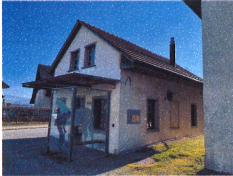
Bildlegende StÜ: Alte Schmitte im heutigen Zustand
